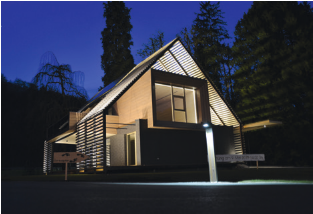
Passivhaus Eisenstraße. Symbol für eine kooperative und innovative Grundhaltung der Region, errichtet von der Firma Holzbau Strigl aus dem Bergsteigerdorf Lunz am See. © Eisenstraße
