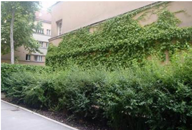
Selbstklimmer an einem Fassadenvorsprung
