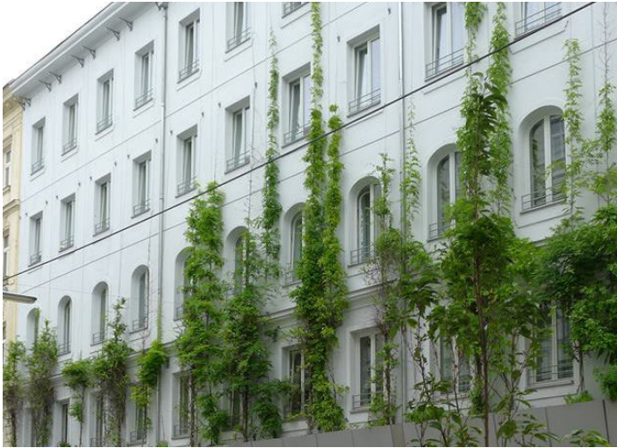
Wohnhausanlage Embelgasse, 1050 Wien Fassadentröge mit Kletterpflanzen und Rankseilen © GSG/VfB
