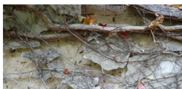
Abbildung 4: Sanierungsbedürftiges Mauerwerk (Quelle: Schaufler 2011)
