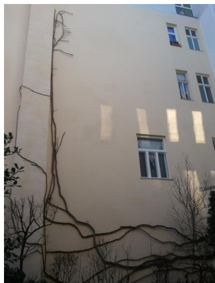
Abbildung 10: Die Fassade nach der Fertigstellung Ende Dezember 2011 (Quelle: Schaufler 2011)
