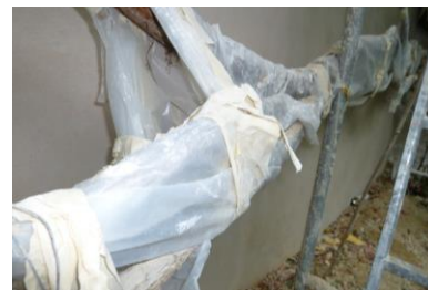
Abbildung 5 : Die am Baugerüst befestigten, eingepackten Haupttriebe (Quelle: Schaufler 2011)
