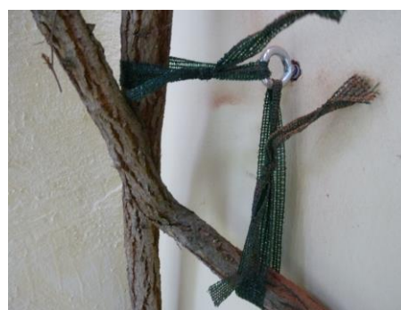
Abbildung 8: Mittels Rundhaken und Geotextil an der Fassade befestigte Haupttriebe (Quelle: Schaufler 2011)
