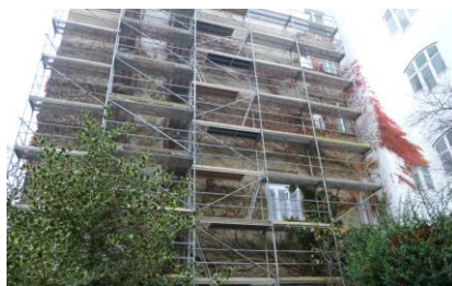
Abbildung 3: Das Baugerüst (Quelle: Enzi 2011)
