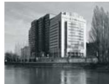
BIG Zentrale Hintere Zollamtsstrasse, Wien
