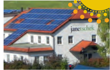
Photovoltaikanlage auf dem Dach unserer Zentrale in Heidenreichstein
